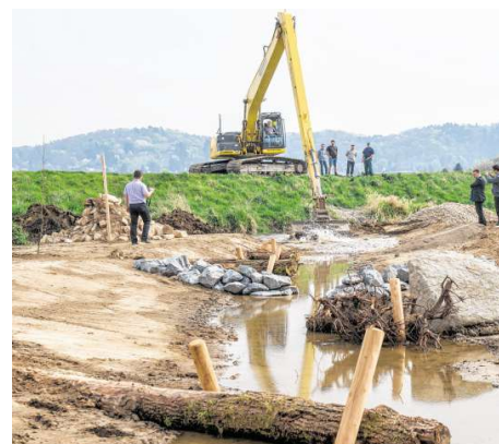
Zahlreiche Renaturierungsmaßnahmen – wie hier am Winkelbach bei Bensheim – wirken sich positiv auf Fischartenvielfalt in der Region aus. BILD: NEU
