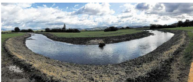
Ein nagelneuer Fluss bahnt sich seinen Weg: Gestern lief die Alte Weschnitz in ihr frisch angelegtes Bett, wo das Wasser aus der Neuen Weschnitz schon wartete. Am Wochenende steht noch einmal eine Fischrettungsaktion an.
